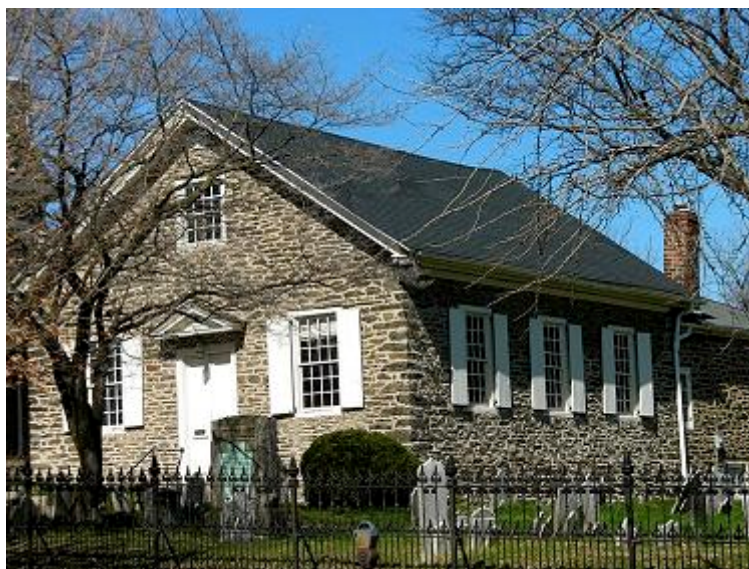
Casa de encontro Menonita numa cidade da Alemanha construída em 1770 –
