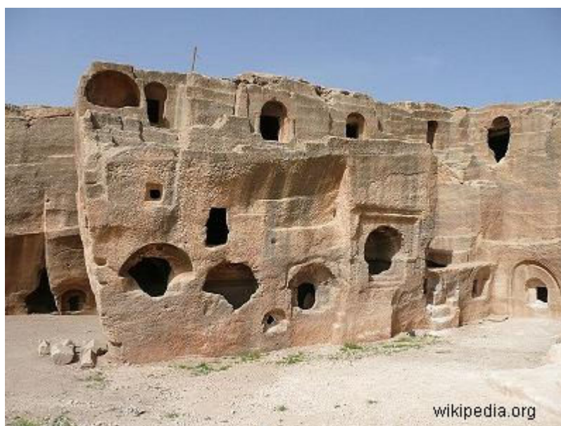
Ruínas de um edifício em Dara
